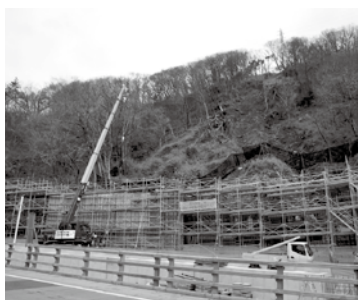
138号線、台風19号災害復旧工事現場
