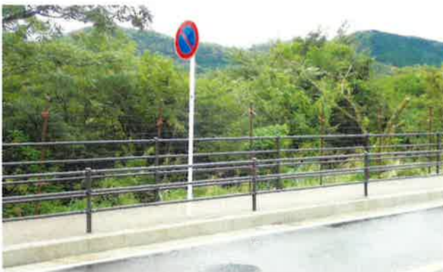
写真Ⅱ-11 地点B 歩道沿い
