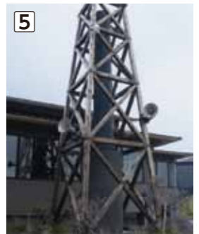
園地内放送設備
