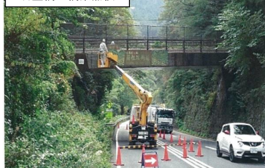
石畳橋の橋梁点検
