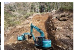
2号えん堤整備箇所 (掘削状況)
