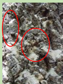
穿孔孔の状況
