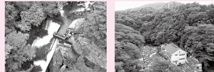
堂ヶ島溪谷にある早川取水堰堤(左)から塔之沢発電所(右)までおよそ3.2kmの導水路があり、その内2.9kmは山を掘ったトンネルとなっています。
