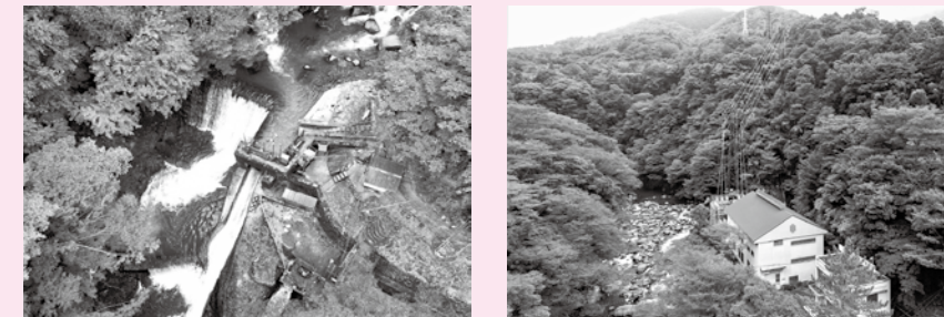
堂ヶ島溪谷にある早川取水堰堤(左)から塔之沢発電所(右)までおよそ3.2kmの導水路があり、その内2.9kmは山を掘ったトンネルとなっています。
