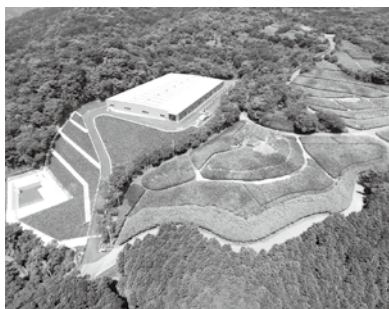
新しく建設された湯河原町真鶴町衛生組合の最終処分場
