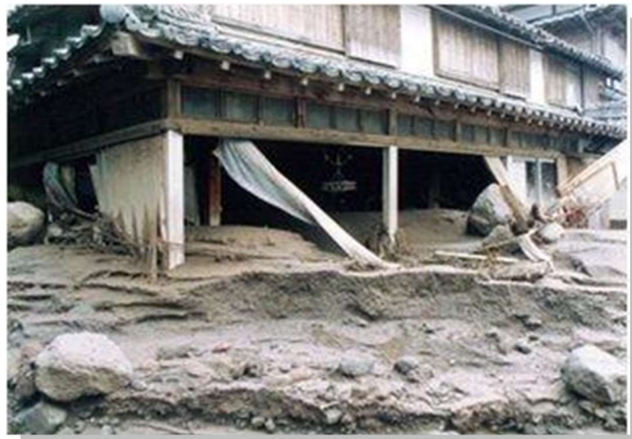
写真 4 土石流被害を受けた家屋 （国土交通省九州地方整備局雲仙復興事務所提供）
