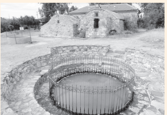
写真1 ギリシア、レスボス島ユネスコ世界ジオパークのポリクニトス温泉の源泉井と湯室の建屋
