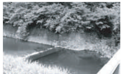
仙石原浄水センター処理水放流口付近
