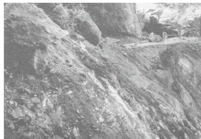
塔之澤上部の国道が決壊した様子
