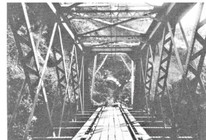
入口がふさがってしまった出山鉄橋の様子
